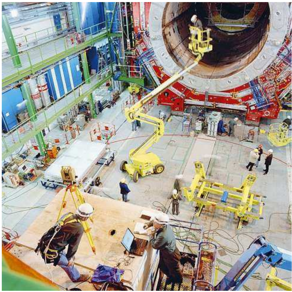
2007: Im Cern wird ein Großgerät montiert, diesmal ein Teilchendetektor. Er steht in 110 Meter Tiefe Foto: Cira/Moro/laif
